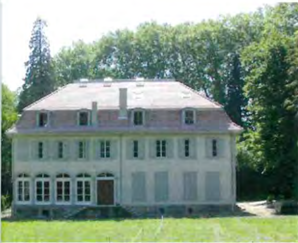
Le château de Dorigny a bénéficié du système et les murs ont perdu leur humidité.
